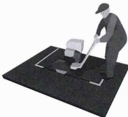
Figura 2 - Corte e remoção do revestimento asfáltico.
