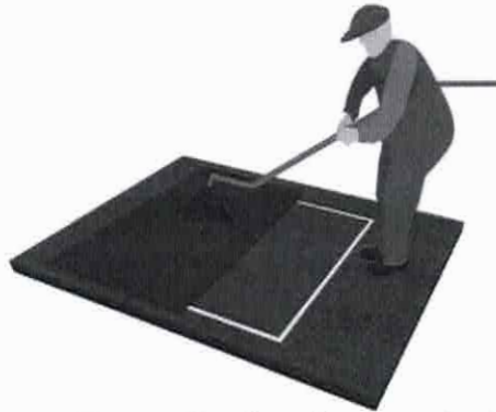
Figura 3 - Execução da pintura de ligação.
