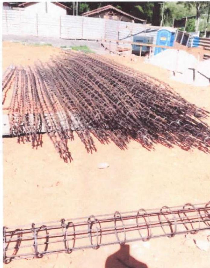
Foto 4.: Ferragem muro de arrimo.
