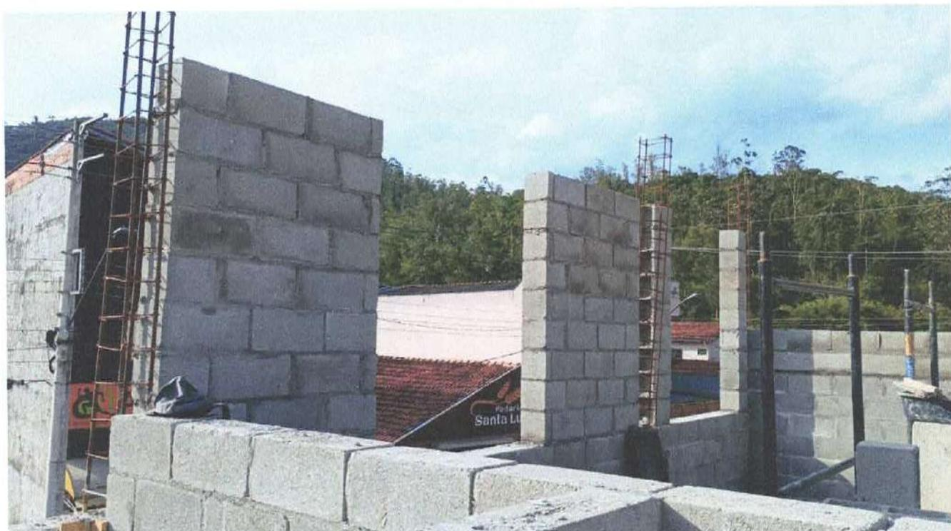
Foto 2: Alvenaria do 2º Pavimento
