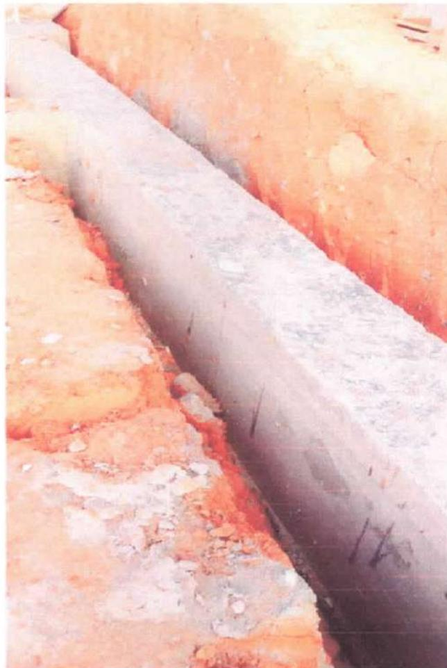
Foto 1: Desfôrma das vigas baldrame e blocos de coroamento
