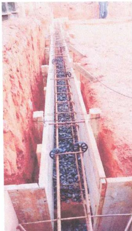
Foto 30 e 31: Montagem da forma e colocação do lastro de brita da viga baldrame.
