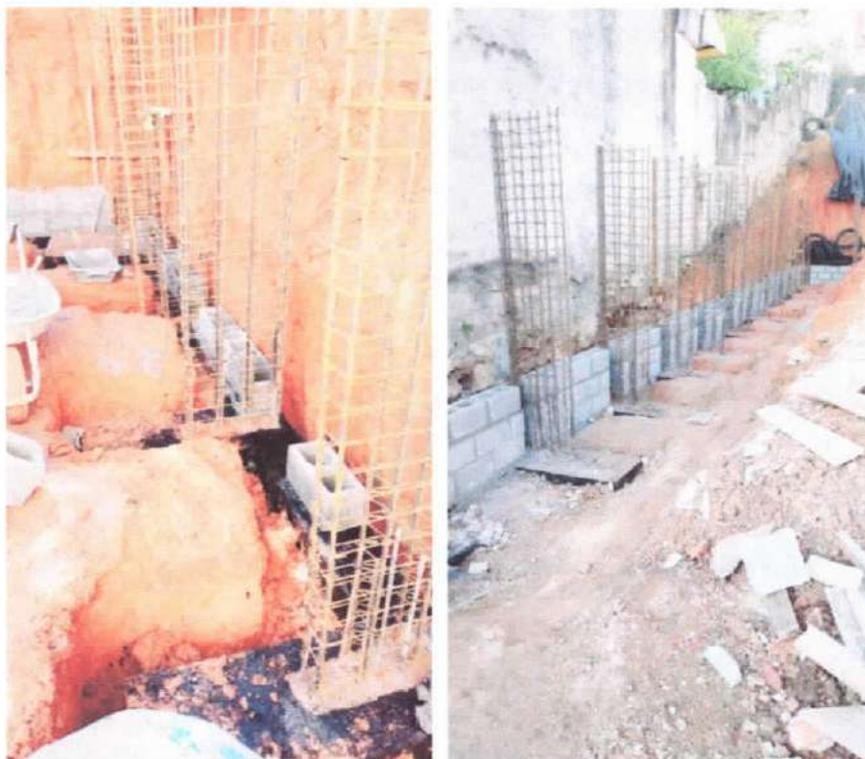
Foto 29 e 30: Elevação do muro de arrimo.
