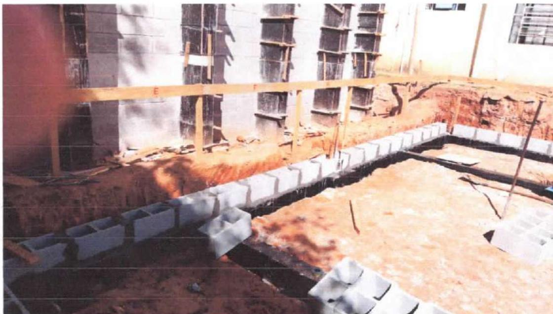
Foto 4: Assentamento da primeira fiada da alvenaria de blocos de cimento
