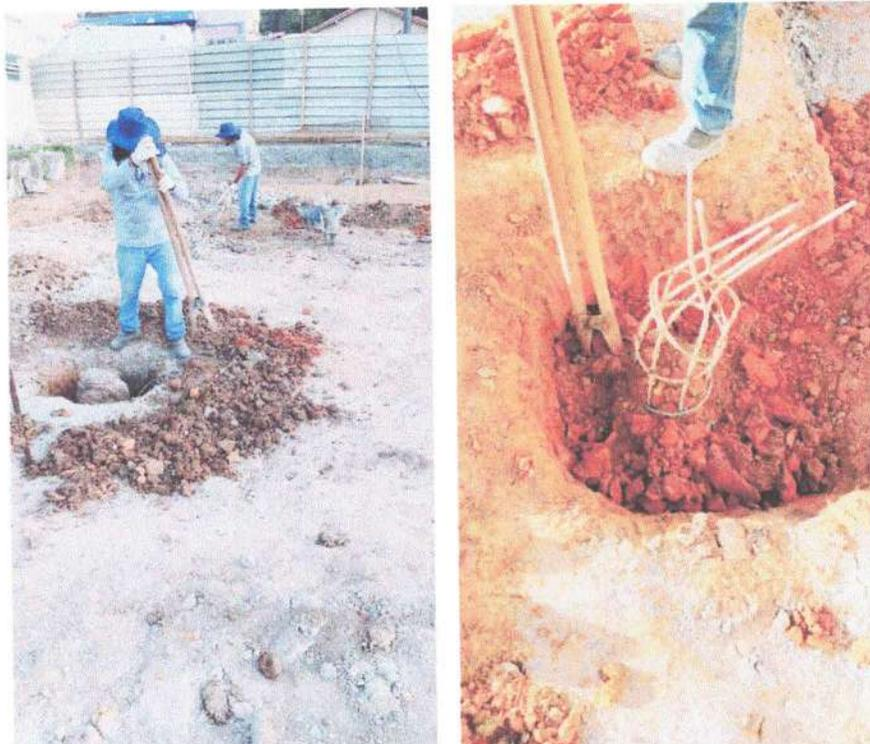
Foto 1 e 2: Abertura das sapatas e arrasamento da cabeça de estaca.
