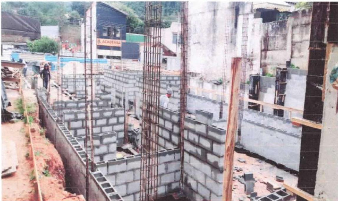
Foto 7: Assentamento da alvenaria de blocos de cimento
