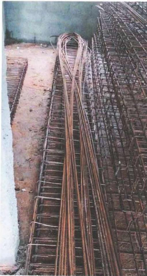
Foto 1: Ferragem das vigas e pilares
