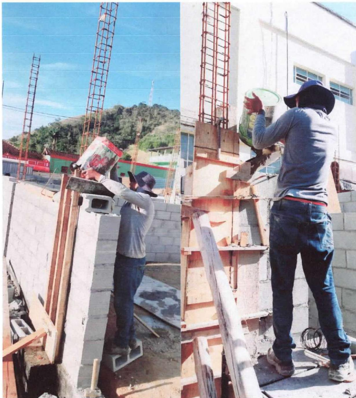
Foto 3 e 4: Concretagem dos pilares
