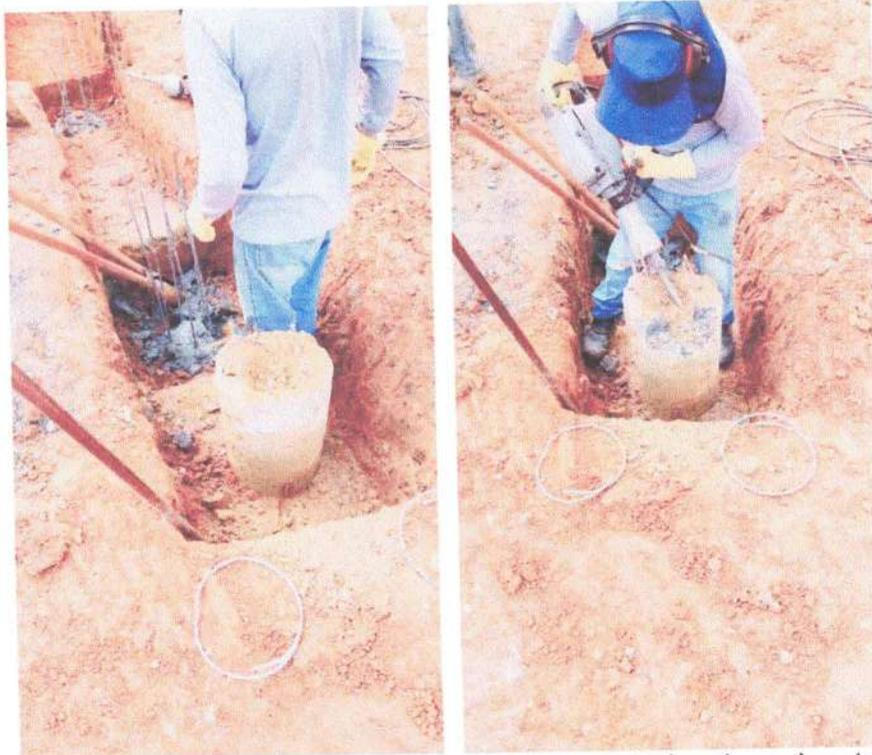
Foto 9 e 10: Abertura das sapatas e arrasamento da cabeça de estaca.
