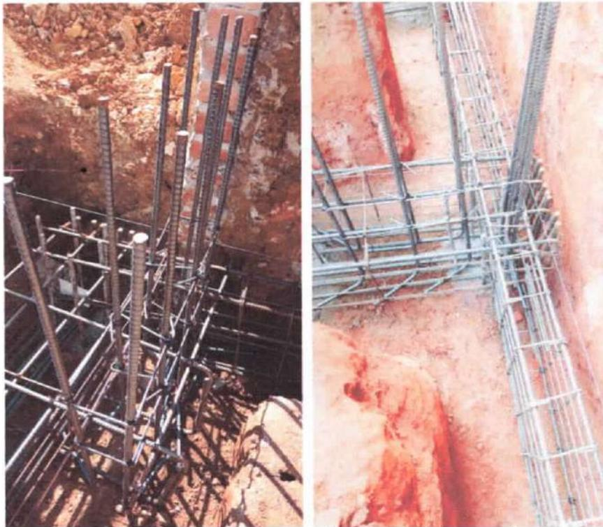
Foto 14 e 15: Execução da ferragem das vigas baldrame e dos blocos.
