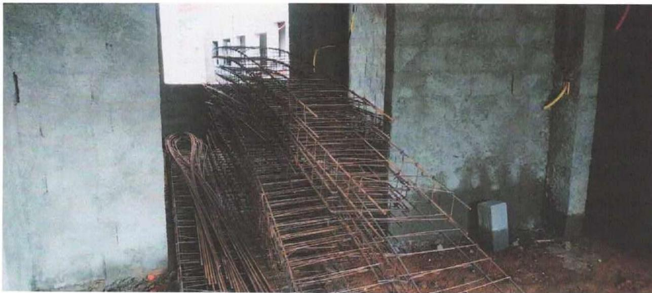
Foto 2: Ferragem das vigas e pilares
