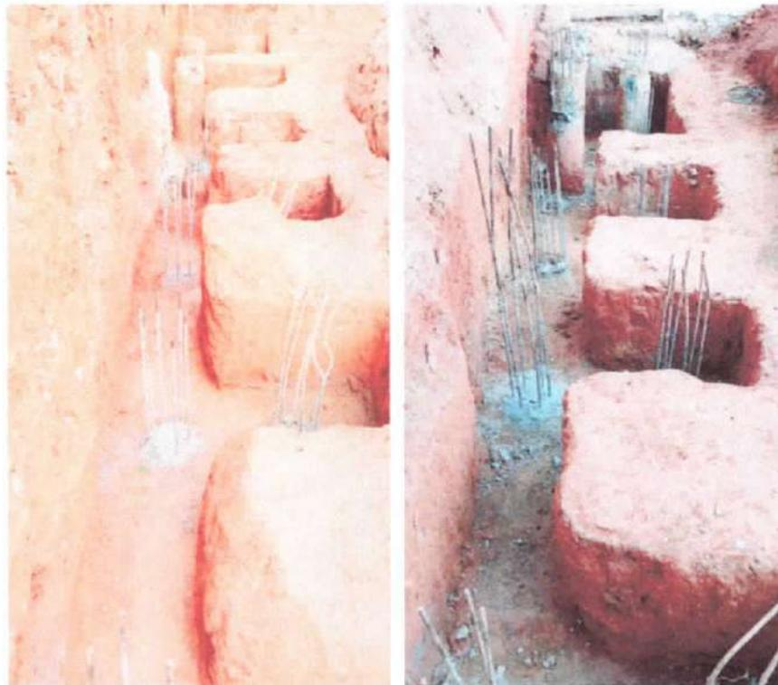
Foto 10 e 11: Arrasamento da cabeça da estaca do muro de arrimo.
