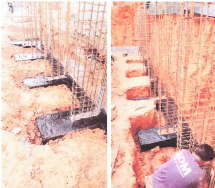
Foto 27 e 28: Aplicação de impermeabilizante nos blocos e nas vigas baldrame
