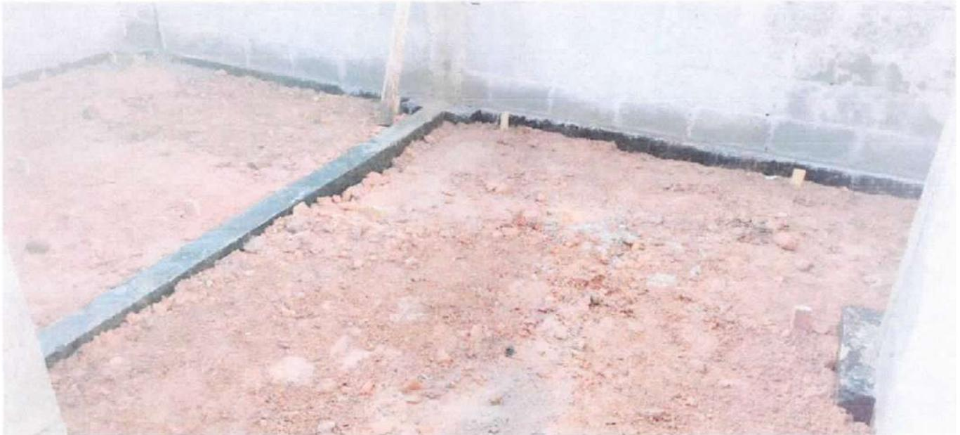
Foto 11: Preparação do solo com brita para a concretagem
