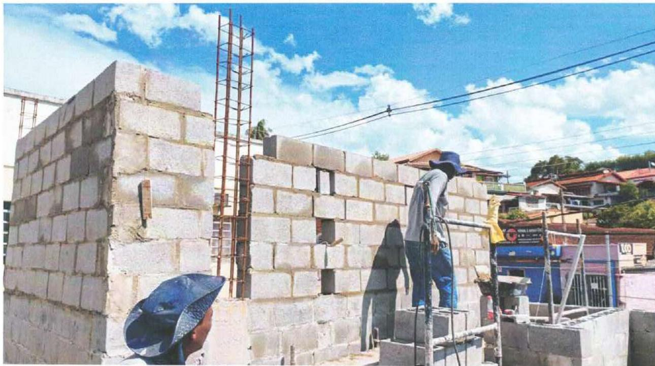
Foto 4: Alvenaria do 2º Pavimento
