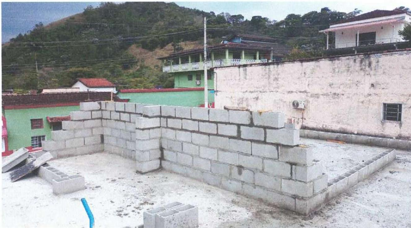
Foto 2: Elevação da alvenaria do 2º Pavimento
