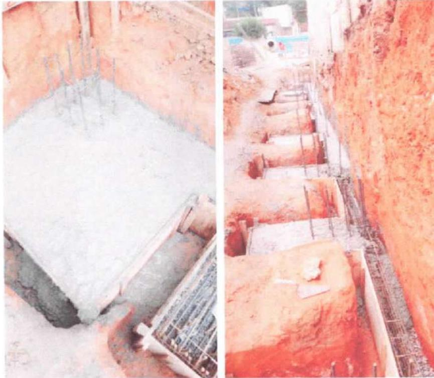
Foto 19 e 20: Concretagem das vigas baldrame e dos blocos.
