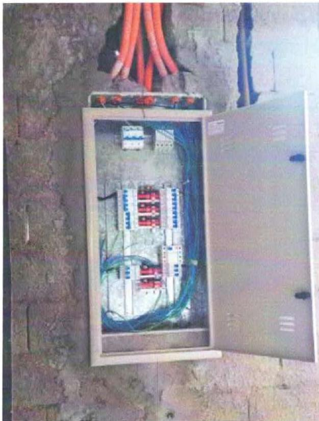
Foto 8: Instalação de quadro e disjuntores.
