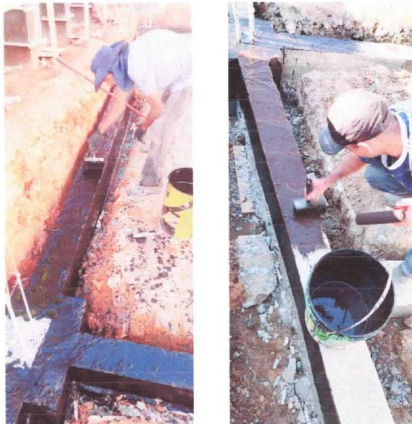
Foto 2: Impermeabilização com impermeabilizante asfáltico nas vigas baldrame e blocos de coroamento
