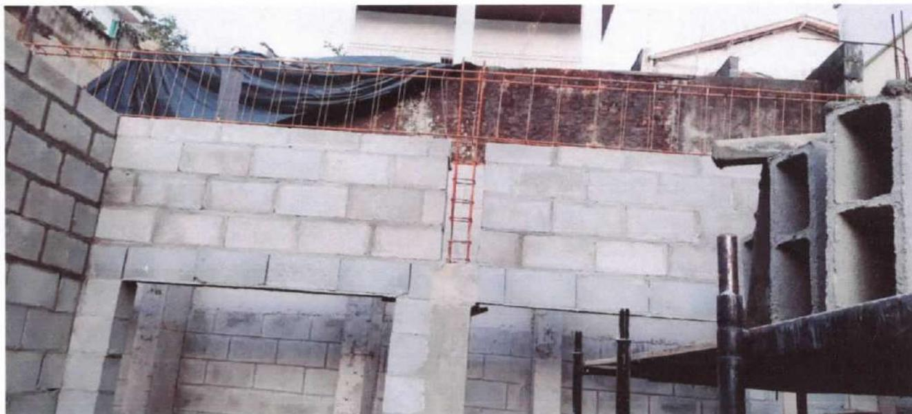
Foto 18: Colocação das vigas sobre as paredes
