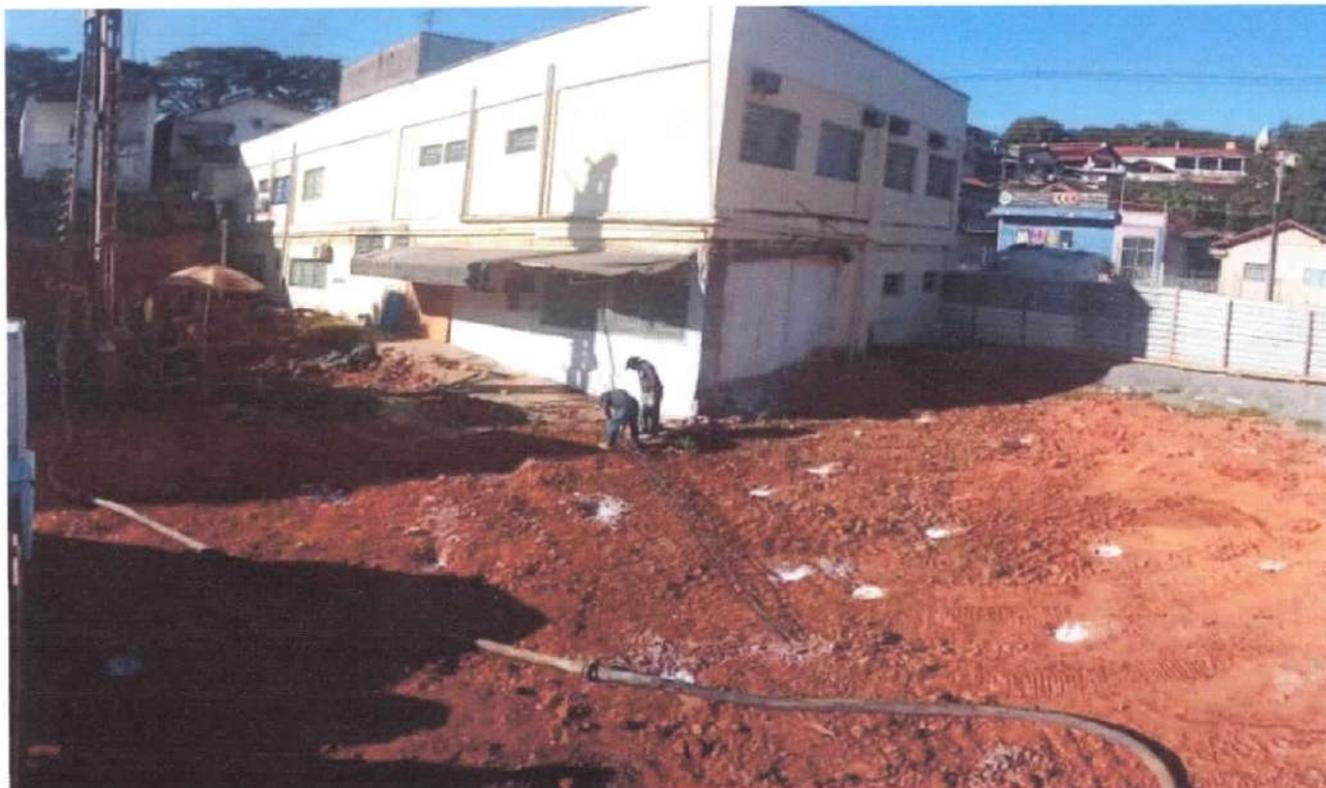
Foto 12.: Execução de estaca hélice contínua.
