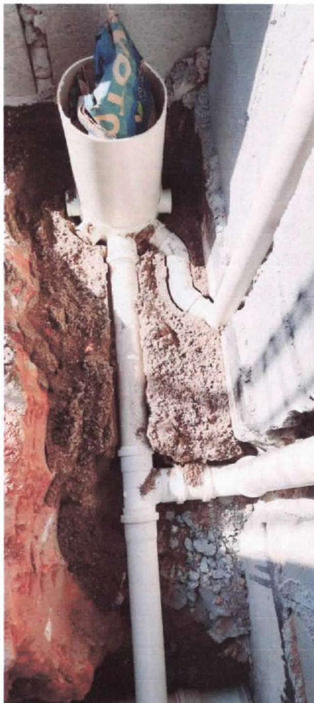
Foto 10: Escavação para colocação das caixas sifonadas e tubulação de esgoto
