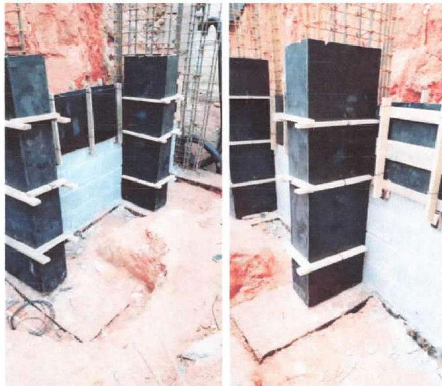
Foto 38 e 39: Execução das formas dos pilares e da viga intermediária.
