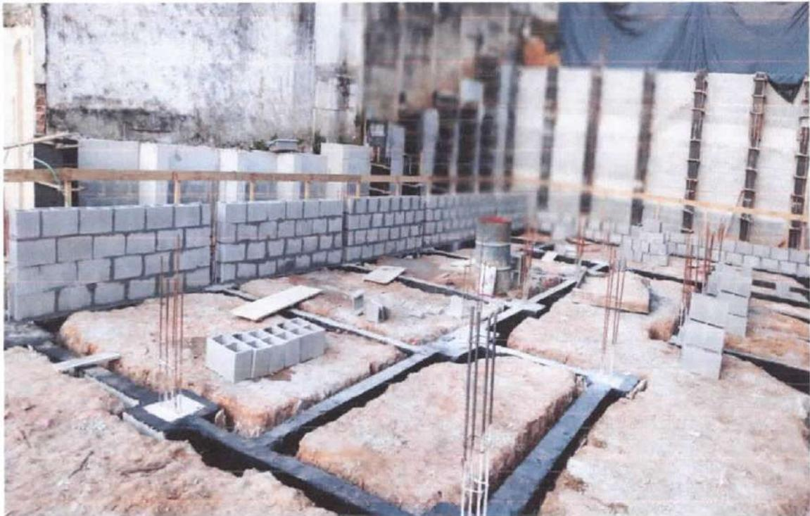
Foto 6: Assentamento da alvenaria de blocos de cimento
