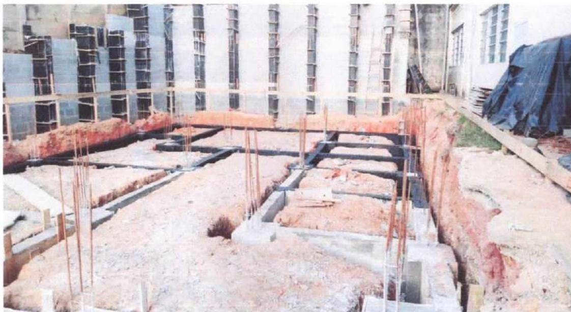
Foto 3: Impermeabilização com impermeabilizante asfáltico nas vigas baldrame e blocos de coroamento
