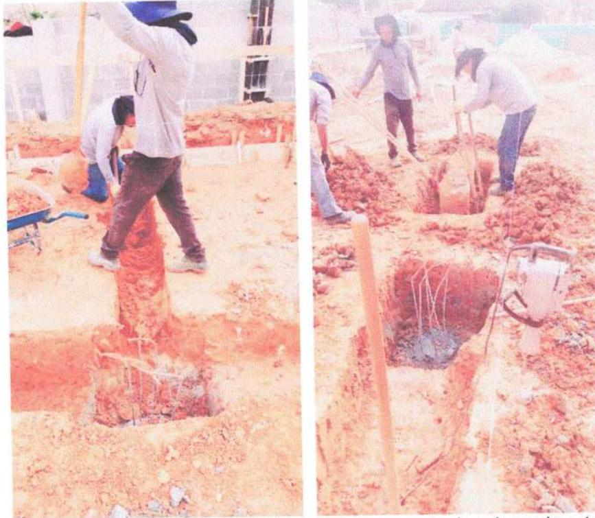
Foto 15 e 16: Abertura da viga baldrame e arrasamento da cabeça de estaca.
