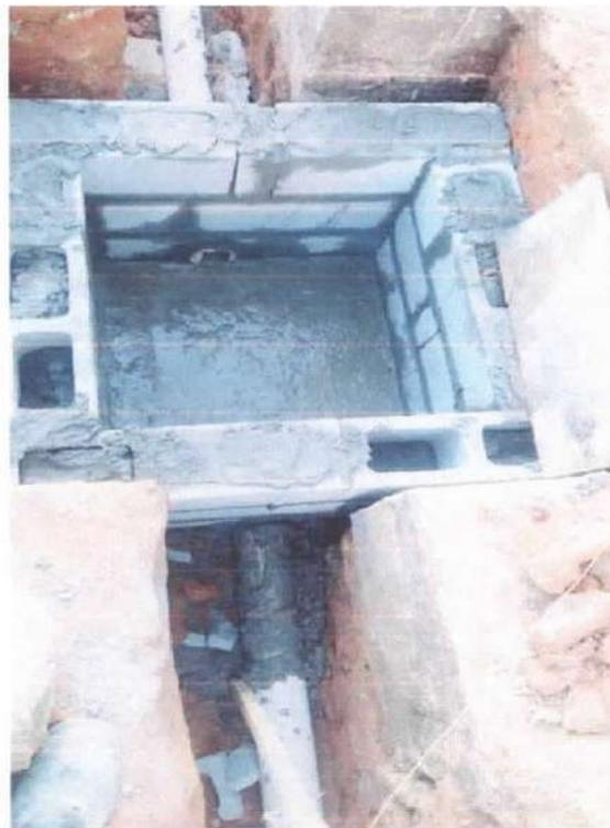
Foto 13: Tubulações e caixas de esgoto
