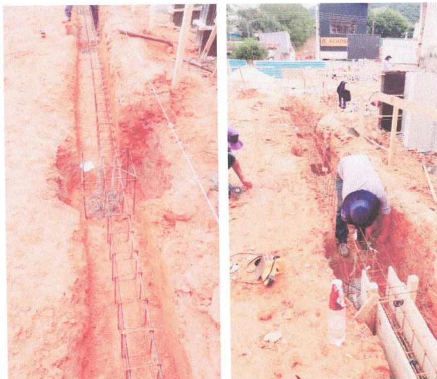
Foto 28 e 29: Montagem da ferragem e forma da viga baldrame.
