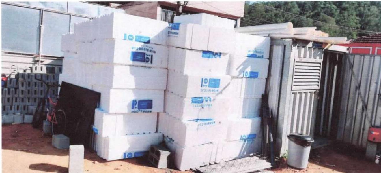
Foto 20: Separação do EPS para montagem da laje.
