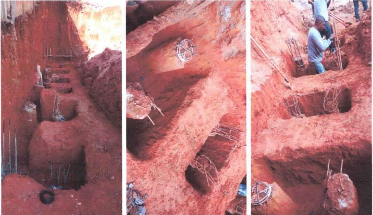
Foto 7, 8 e 9: Escavação da fundação do muro de arrimo.
