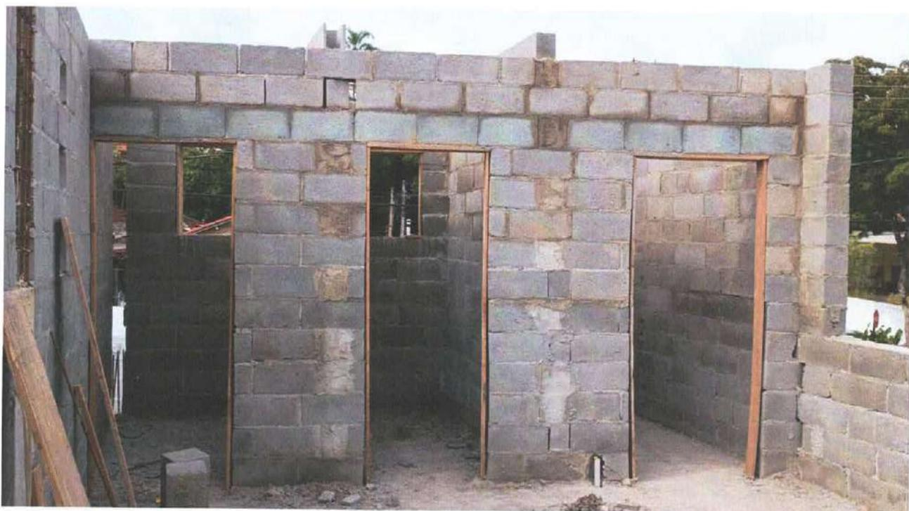
Foto 3: Alvenaria do 2º Pavimento
