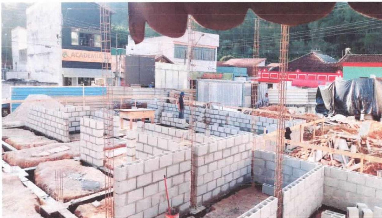
Foto 8: Assentamento da alvenaria de blocos de cimento
