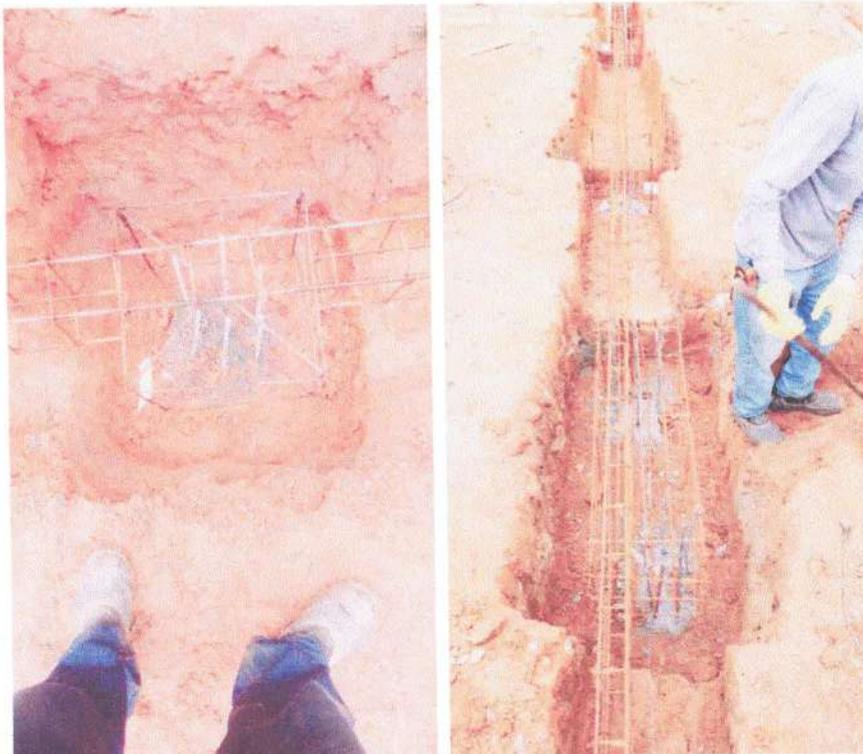
Foto 26 e 27: Montagem da ferragem da viga baldrame.
