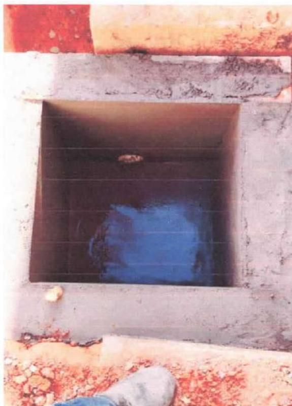
Foto 11: Reboco das caixas de esgoto
