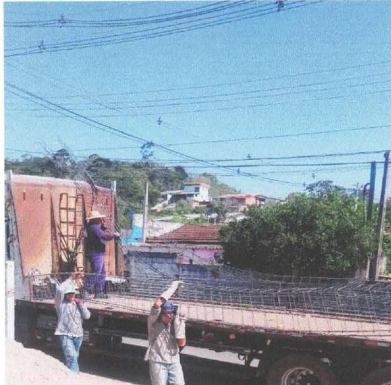
Foto 7: Ferragem das vigas do 2º Pavimento
