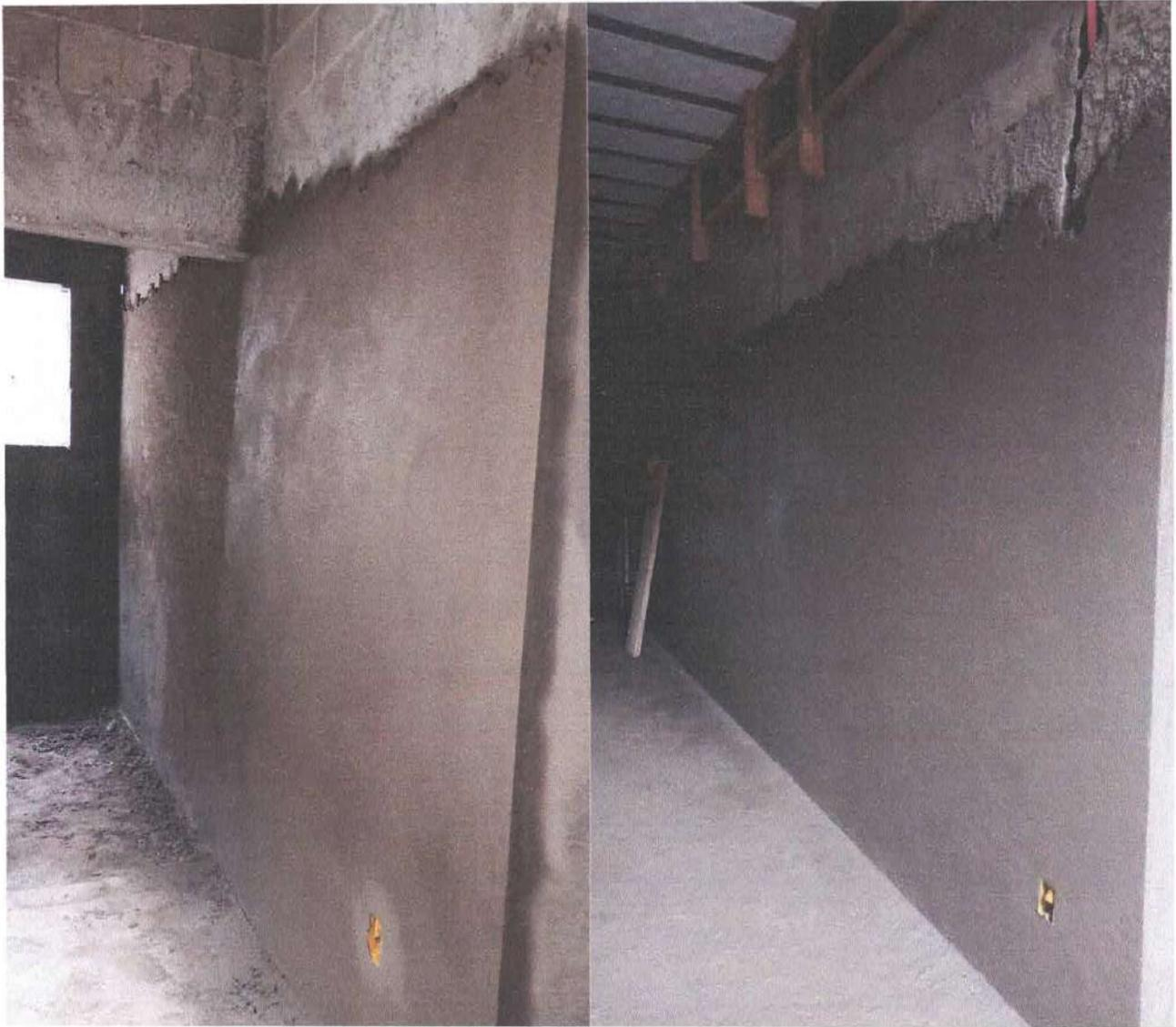
Foto 5: Reboco do 1º Pavimento área interna
