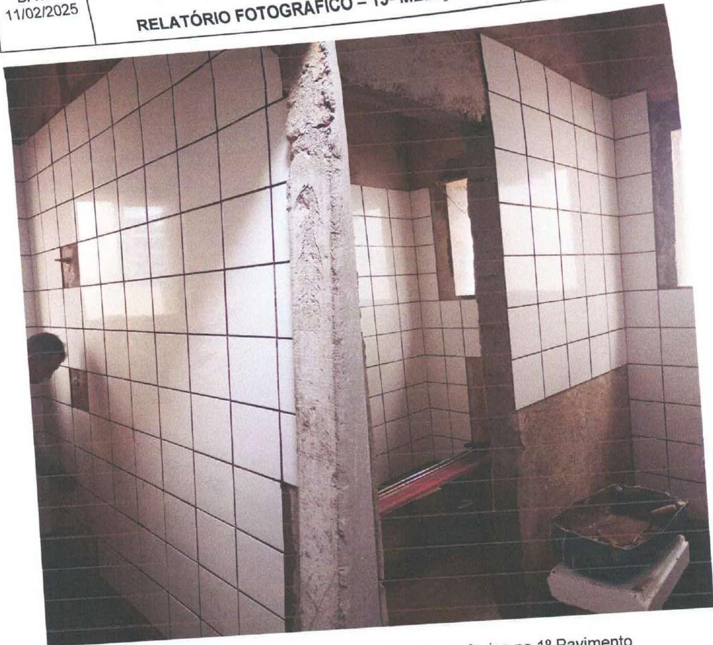
Foto 4 e 5: Assentamento do revestimento cerâmico no 1º Pavimento
