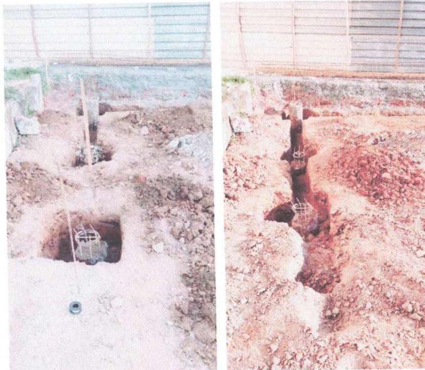
Foto 11 e 12: Abertura da viga baldrame e arrasamento da cabeça de estaca.
