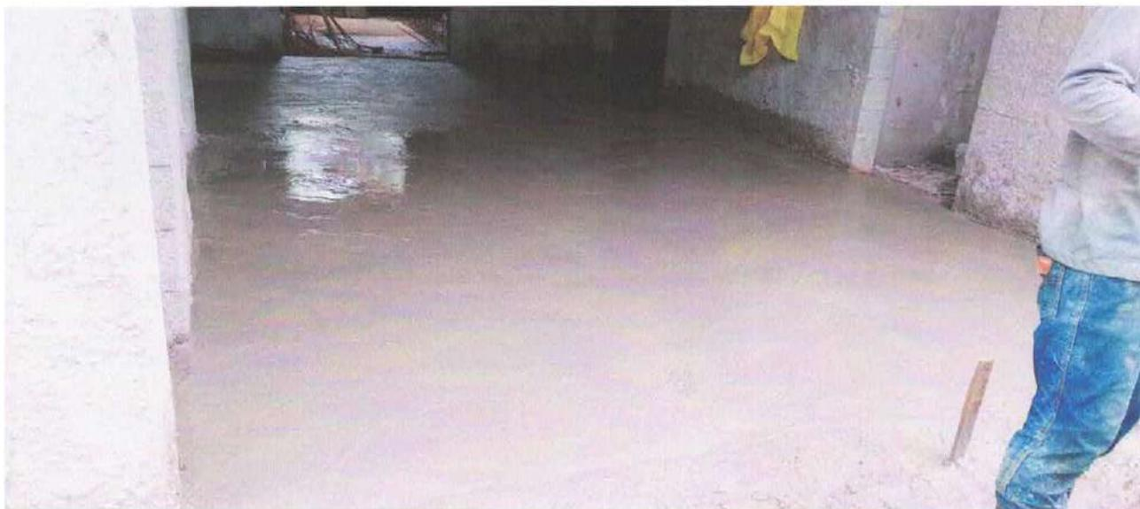
Foto 6: Concretagem do piso do 1º Pavimento
