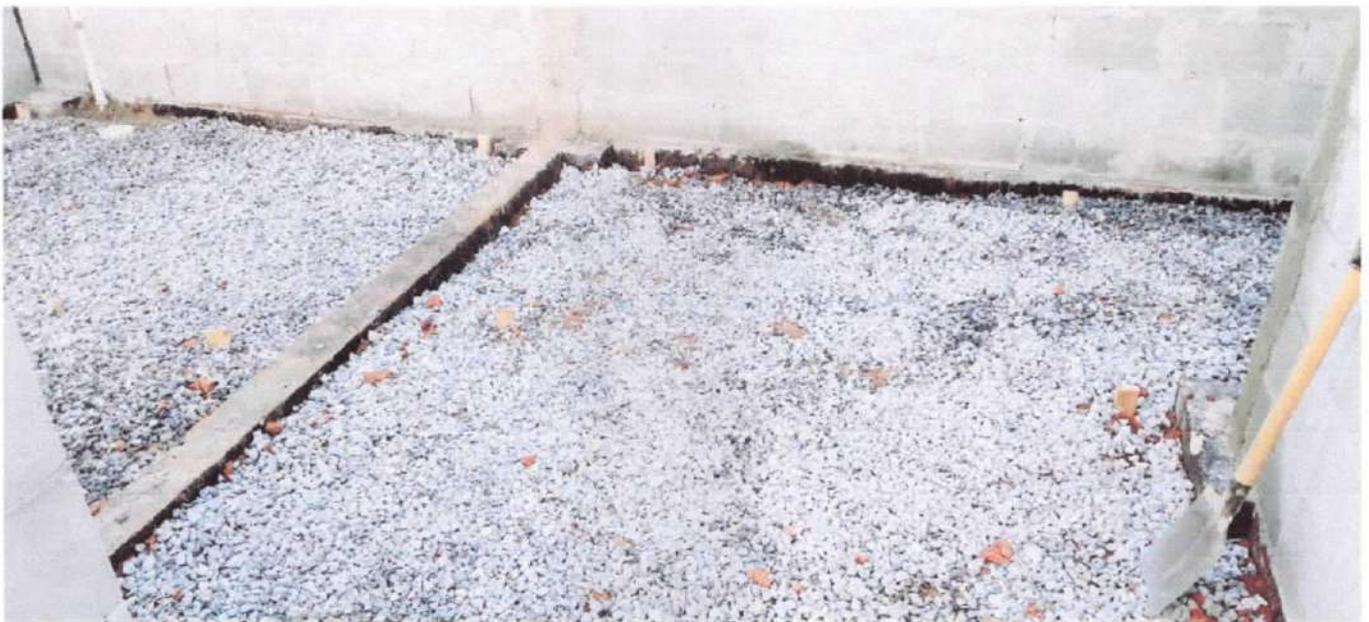
Foto 12: Preparação do solo com brita para a concretagem
