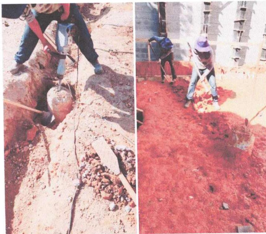
Foto 13 e 14: Abertura da viga baldrame e arrasamento da cabeça de estaca.
