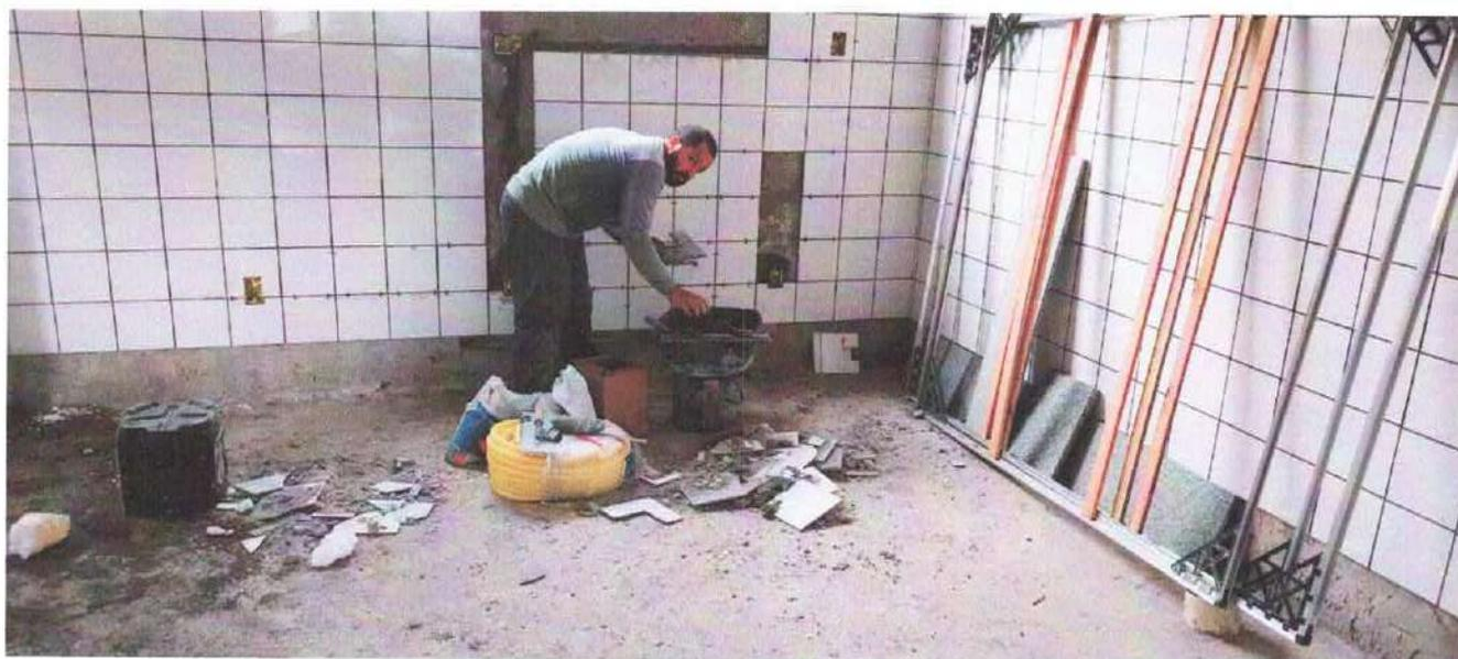
Foto 5: Assentamento de revestimento cerâmico
