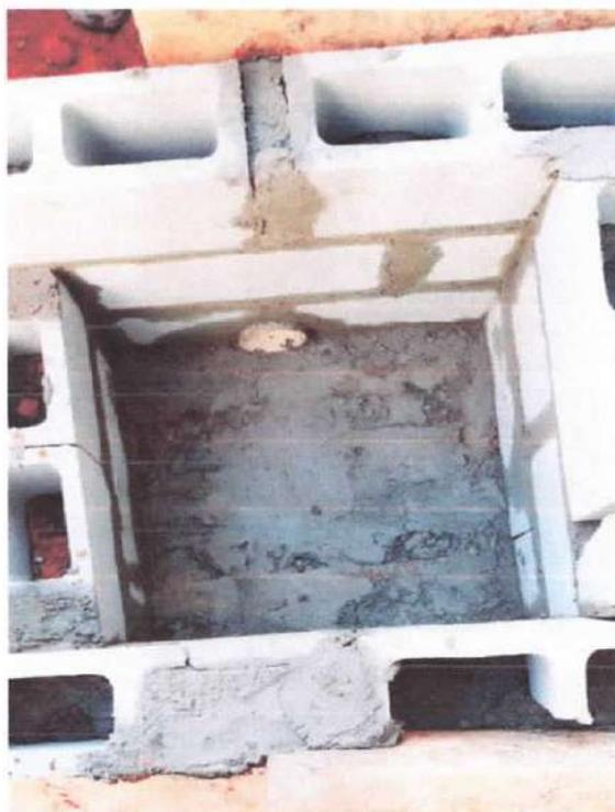
Foto 10: Alvenaria das caixas de esgoto
