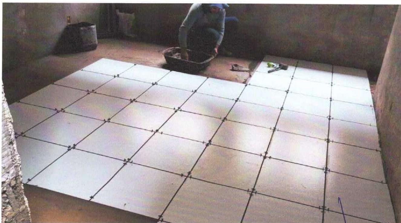
Foto 13: Instalação de piso cerâmico.
