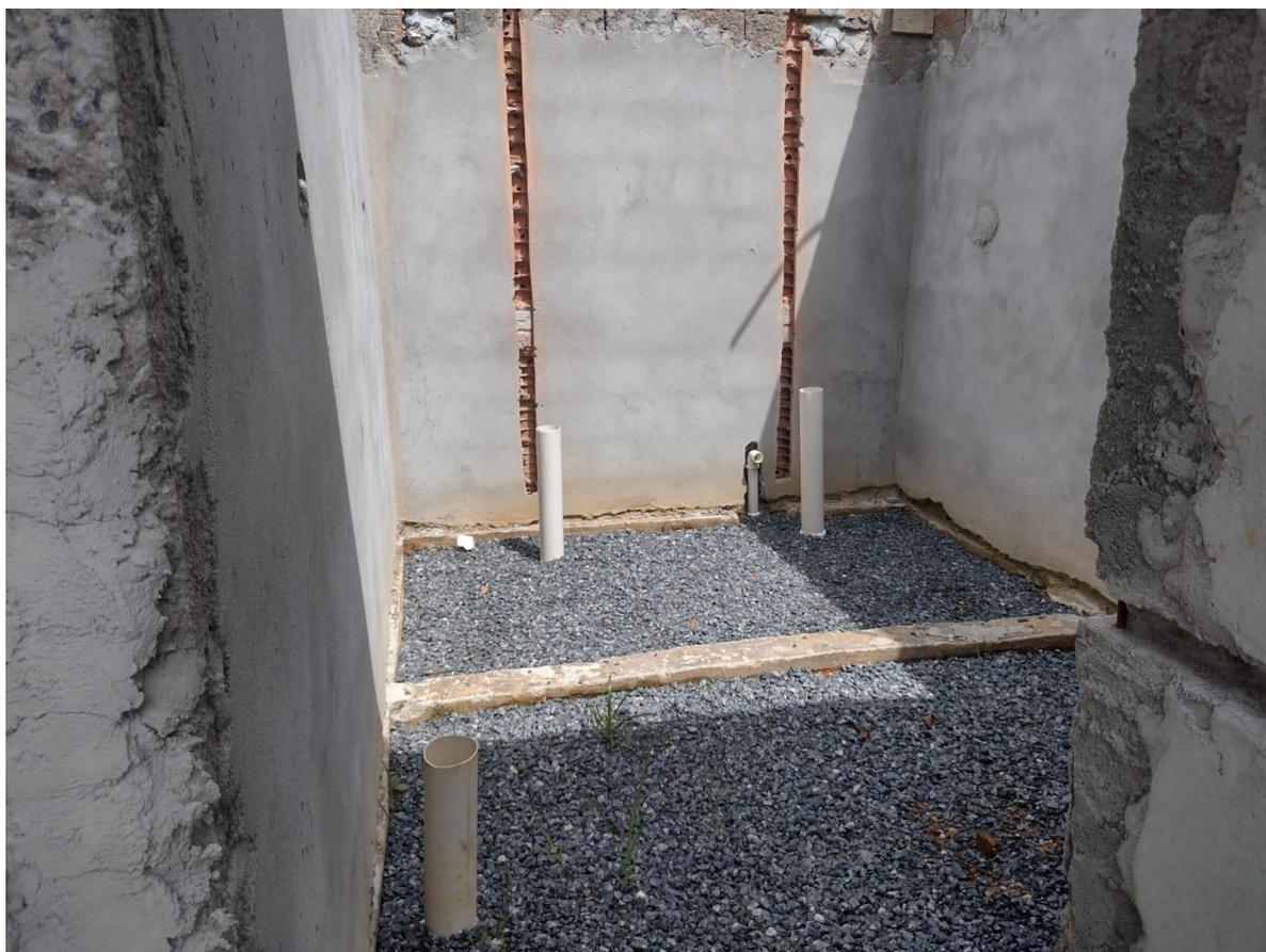
**Foto 7 – Rasgos em parede para inserção das instalações.**
